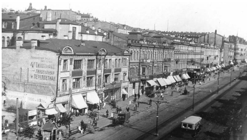
Будинок по Хрещатику, 42 (типографія) та вільна ділянка поруч, на якій розпочалося будівництво. Фото кінця 1920-х рр.
