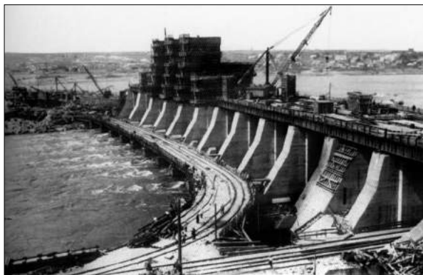
Будівництво греблі Дніпрогесу ім. В. Леніна. Загальний вигляд, 1929.
