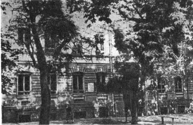
Будівлю по вулиці Петра Великого в Одесі, де містилося Центральне Бюро болгарських комуністичних груп.
