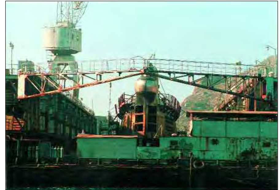
„Запоріжжя” на ремонті в плавдоку ПД-51 (Балаклава)
