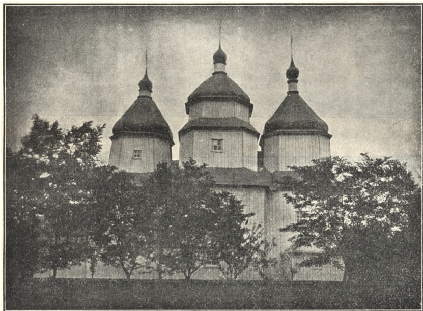
7. Церква в с. Россошках Уманського пов., збудована Іваном Гонтою.
