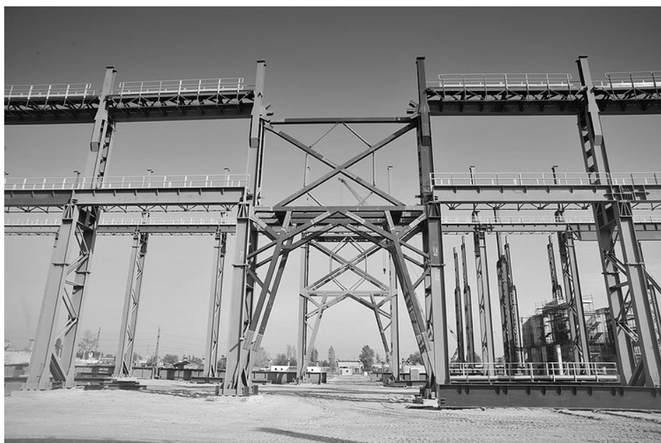
Stahlbau von „Interpipe“
