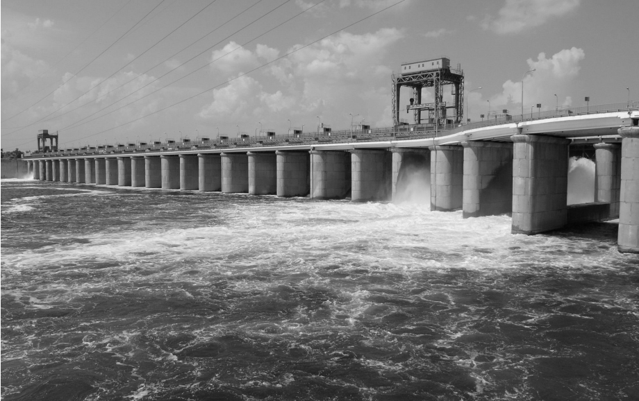
Wasserkraftwerk Kachovka am Dnjepr
