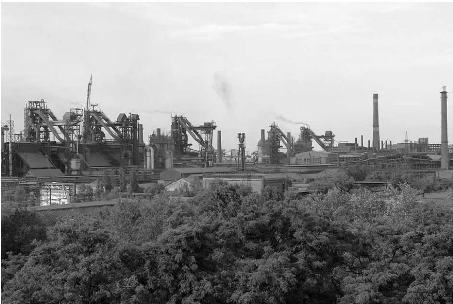
Kraft-Wärme-Kopplung? Dniprovskij-Metallurgiekombinat in Dniprodzeržynsk
